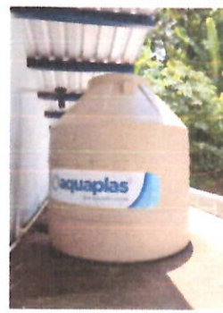
CAMBIO DE ACCESORIOS DE TINACO, FLOTE, CHEQUE, TUBERÍA INGRESO Y SALIDA
