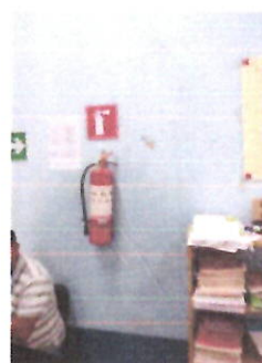
PINTURA, APLICACIÓN DE PINTURA EN PARED AFECTADA POR HUMEDAD POR FILTRACIÓN DE LOSA SOBRE BAÑOS
